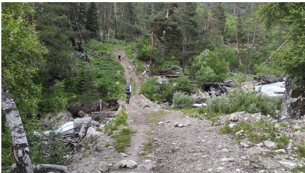
Фото 5.9 Мост через р. Джалпаккол
