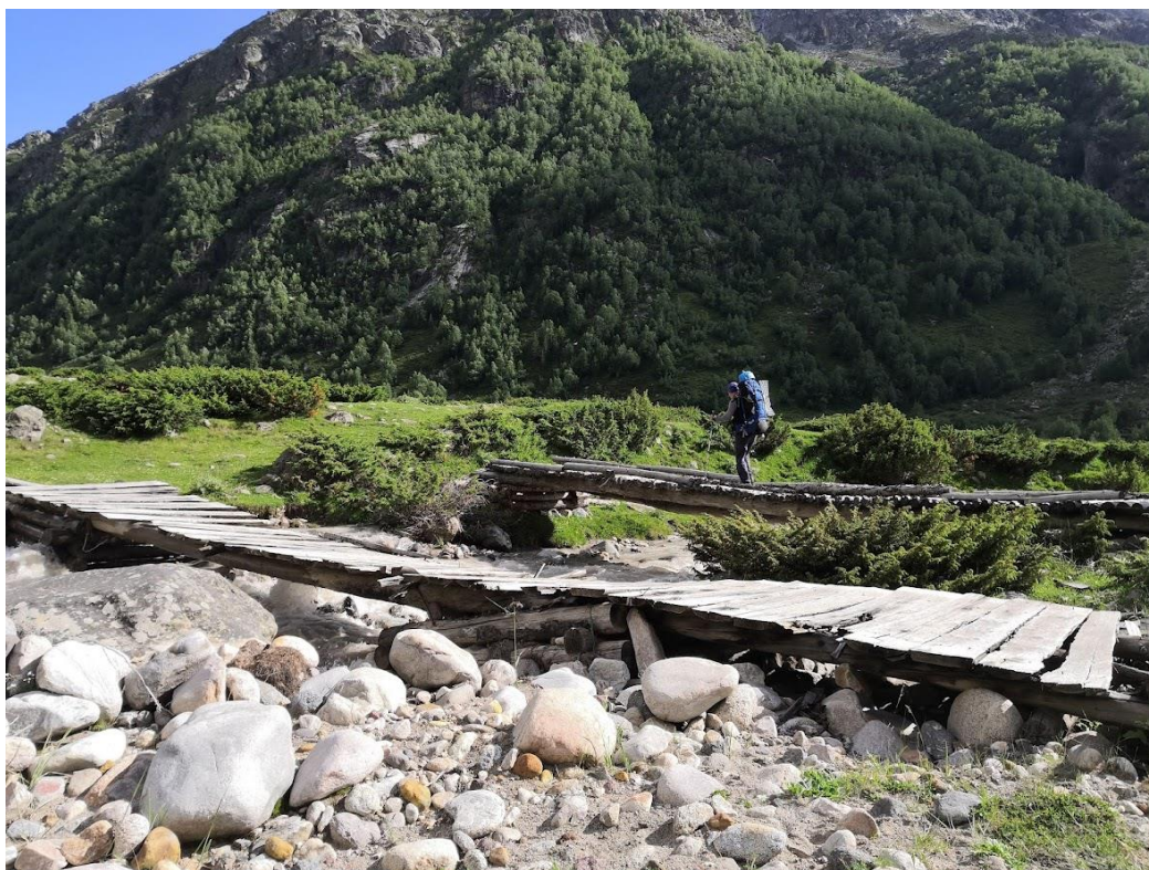
Фото 1. Бревенчатый мост через р. Уллу Кам.
