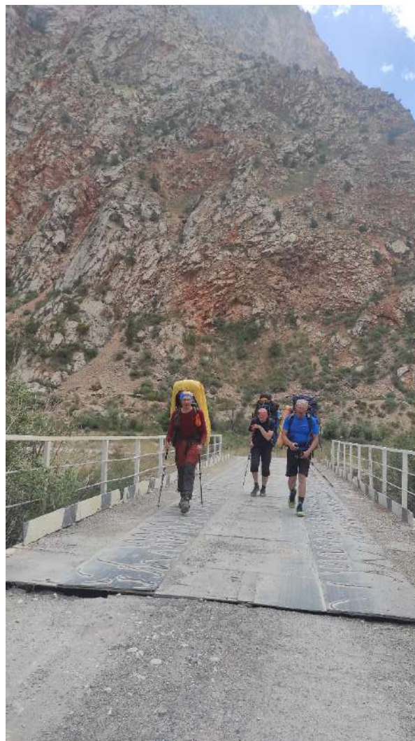
Фото 10. 5. Мост через р. Сарытаг
