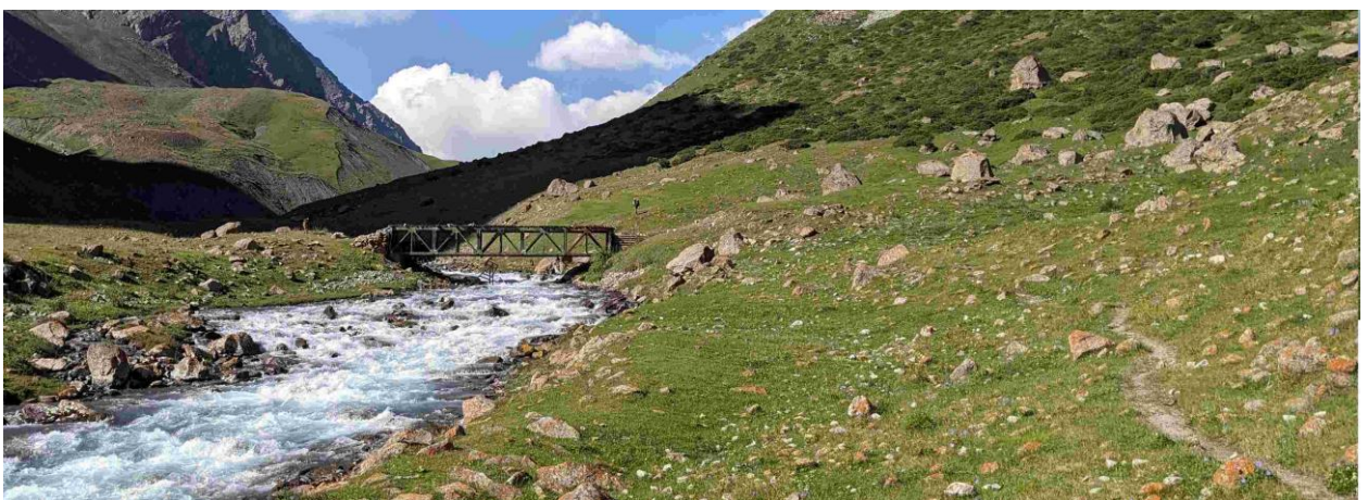
Фото 6. Металлический мост через р.Иссык-Ата.
